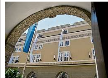
Sanierung nötig: Großes Festspielhaus in Salzburgs Hofstallgasse. FOTO: DPA
